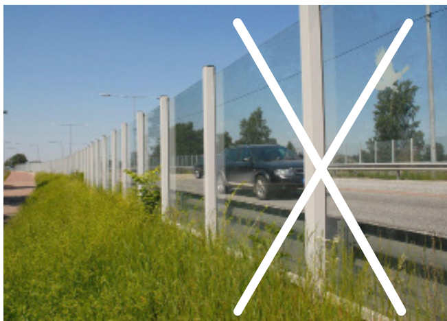
Fåglar kan inte se genomsiktliga skärmar och försöker flyga rakt igenom. Siluetter av rovfågel fungerar inte för att förhindra påflygning. Foto: Mats Lindqvist, Trafikverket.
