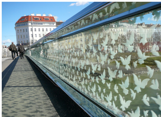
Fågelsiluetter ska endast användas om ytan mellan siluetterna inte är större än 10 cm och båda sidorna förses med siluetter. Denna skärm är från Friedensbrücke i Wien. Foto: Wilfried Doppler, Wiener Umwelthanwaltschaft, Österrike.
