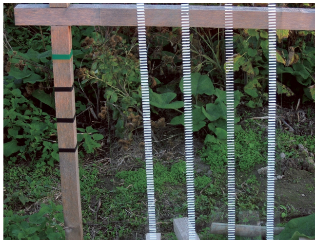
Skärm med horisontella, ljusa linjer längs väg E45 mellan Trollhättan och Göteborg. För störst effektivitet bör mellanrummet mellan ränderna inte vara mer än 10 cm. Foto: Mats Lindqvist, Trafikverket.
