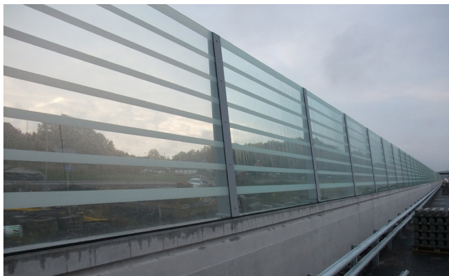
Skärm med horisontella, ljusa linjer längs väg E45 mellan Trollhättan och Göteborg. För störst effektivitet bör mellanrummet mellan ränderna inte vara mer än 10 cm. Foto: Mats Lindqvist, Trafikverket.
